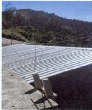
Foto1: Sustrucción de lámina, por lámina troquelada calibre 26 y soporte de madera por metal.
