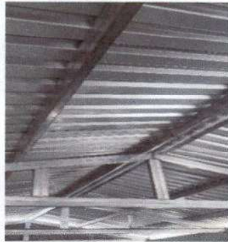
Foto1: Sustrucción de lámina, por lámina troquelada calibre 26 y soporte de madera por metal.
