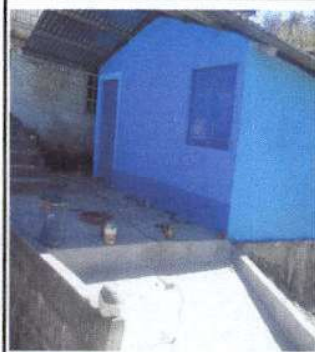
Foto 3: Sustrucción de puerta de madera por metal en cocina y puertas de servicios sanitarios.
